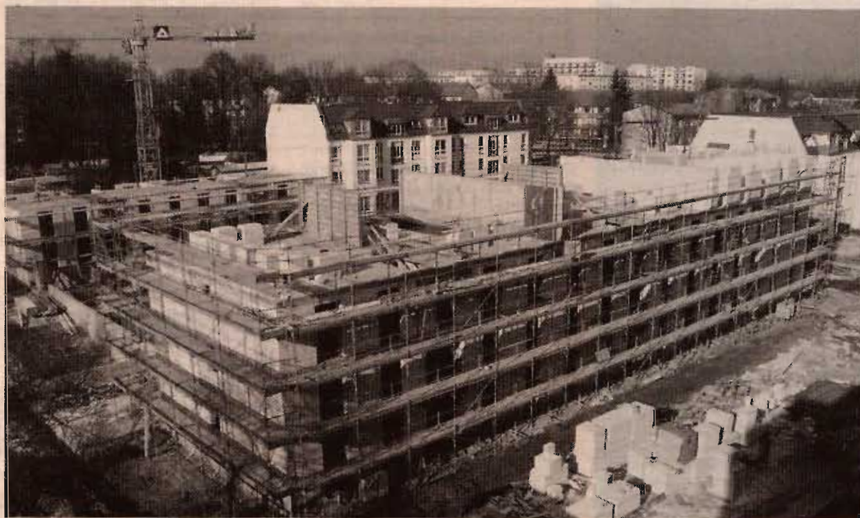
So schnell geht das! Vor fünf Monaten gähnten in der Brusebergstraße die Baugruben. Damals, am 8. Oktober 1998 legte Staatssekretär Ulrich Arndt von der Senatsverwaltung für Bauen, Wohnen und Verkehr hier den Grundstein für unser Neubauprojekt. Mittlerweile sind wir vier Geschosse höher.
