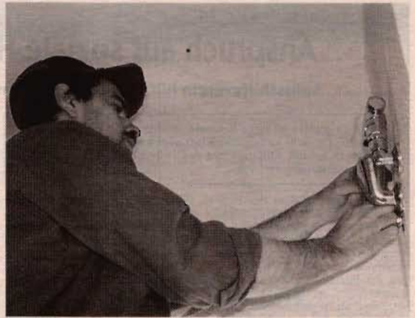
Veba-Installateur Carsten Weber repariert ein undichtes Ventil im Badezimmer. Foto: hard
