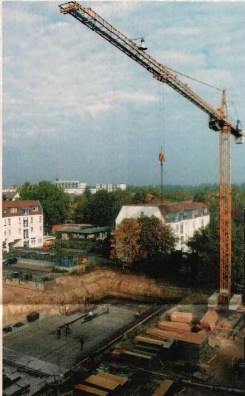
Noch drehen sich die Kräne hoch über den Baugruben. Foto: hard
