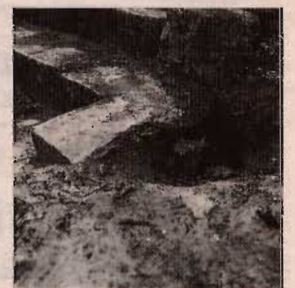
Von Kaninchen unterhöhlte Gartentreppe. Foto: hard
