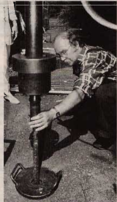
Die Rammsonde gräbt sich bis zu zehn Meter tief ins Erdreich. Foto: Schmidt
