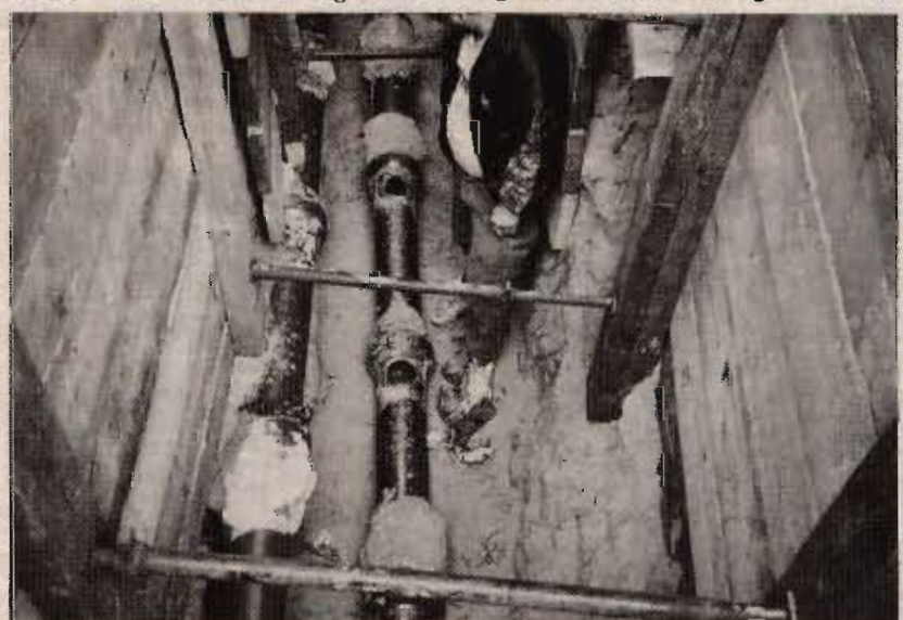
Die maroden Grundleitungen müssen mühsam freigelegt und dann erneuert werden. Foto: Archiv
