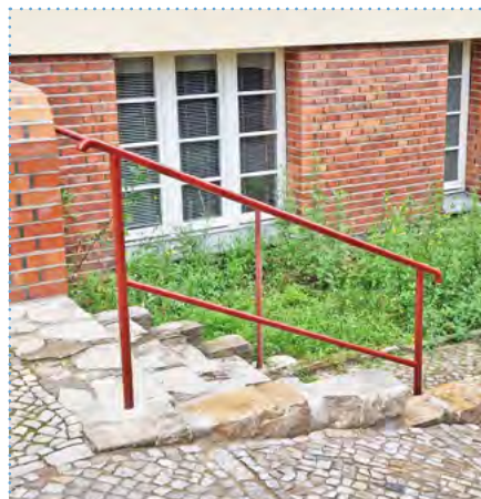
Neues Geländer in Bauteil 8
