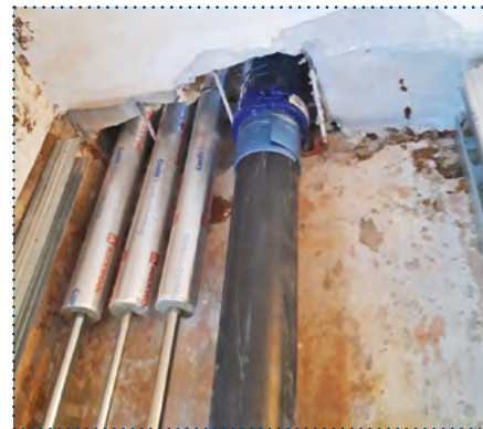
Strangsanierung in den Wohnungen, diverse BT
