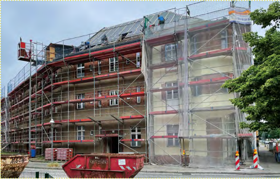
Bauteil 4 – Humboldtstr. 103–104 a, Klenzepfad 2–6, Dach- und Fassadeninstandsetzung in der Ausführung
