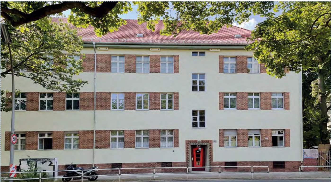
Bauteil 4 – Humboldtstr. 103–104 a, nach der Dach- und Fassadeninstandsetzung.
