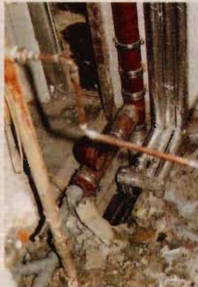
Kurzfristige Verwüstungen unvermeidbar: Strangsanierung im Becherweg.
